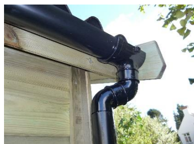
Gutter & Downpipe £12 per linear ft
